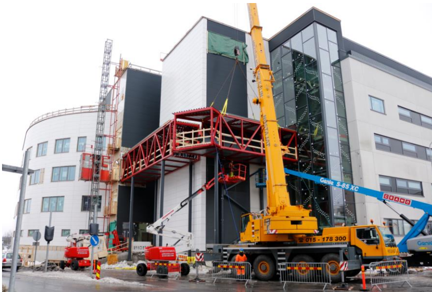
Kuva 3. Sairaalaparkin ja pääsairaalan välisen kävelytunnelin nosto keväällä 2019.
