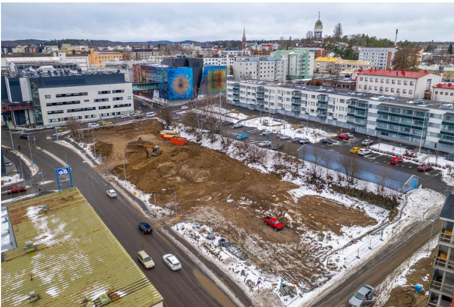
Kuva 11. Maanrakennustyöt Pirtin ja Pultin tontilla Mielen ja kuntoutuksen talon työmaalla.
