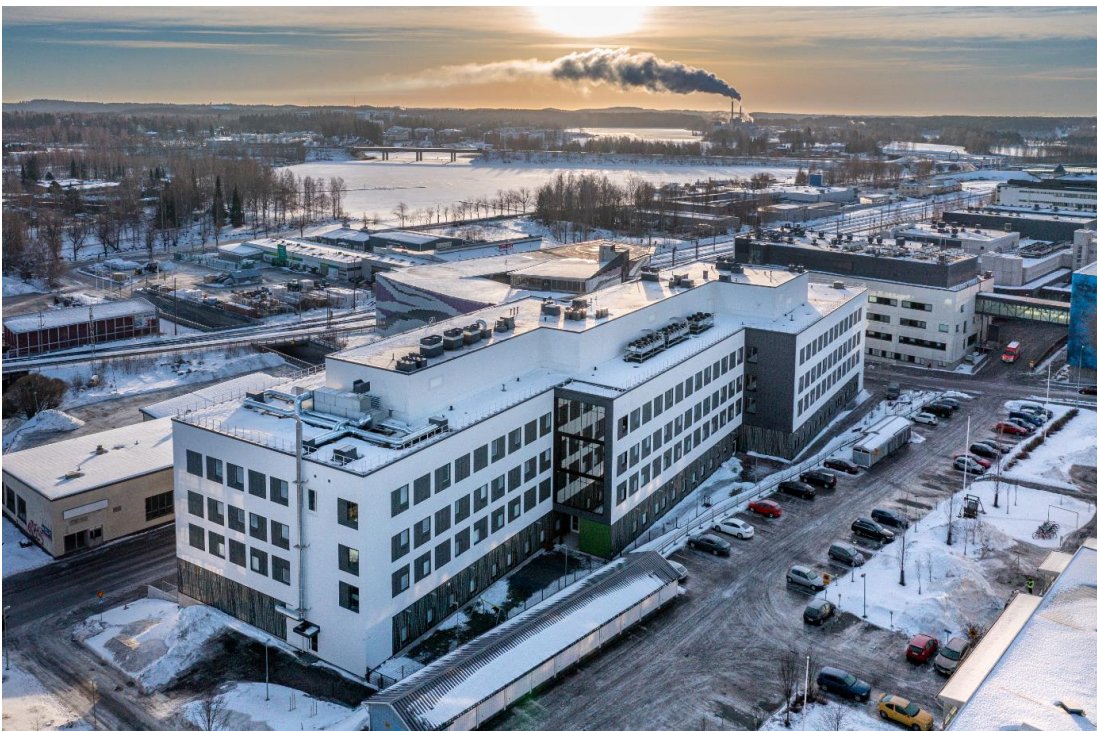
Kuva 8. Vasta valmistunut Mielen ja kuntoutuksen talo loppuvuodesta 2022.
