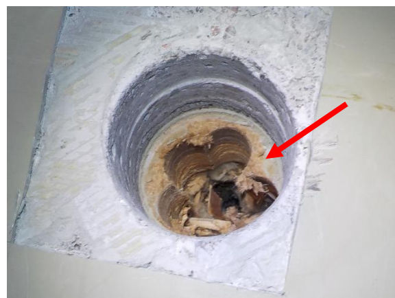
Kuva 42. ASB.04 Vanha lattiapinnoite ja kiinnitysaine
