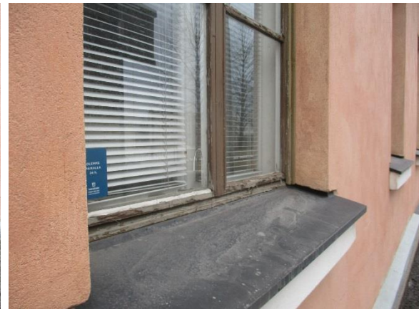
Kuva 29. Ikkunoissa haristumaa ja pinnoitevaurioita
