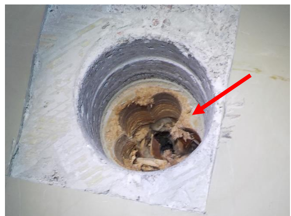
Kuva 15. ASB.04 Vanha lattiapinnoite ja kiinnitysaine
