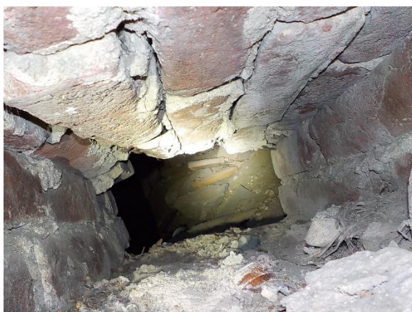
Kuva 5. Tuuletusluukku alapohjaan
