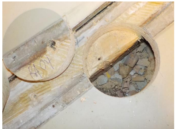
Kuva 4. Yleiskuva rakenneavauksesta RA.04
