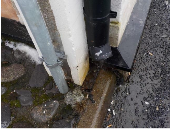
Kuvat 26. ja 27. Sadevesien puutteellinen ohjaus aiheuttaa julkisivurakenteille kosteusrasitusta
