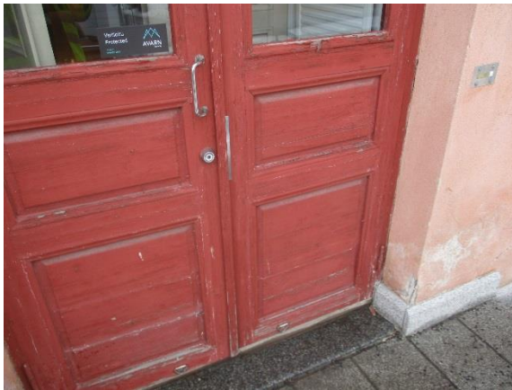
Kuva 28. Ulko-ovissa kulumaa ja vaurioita maalipinnassa
