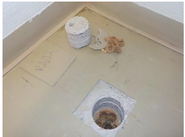
Kuva 2. Yleiskuva rakenneavauksesta RA.02, avauksen ympärillä erilaisia lattiamateriaaleja
