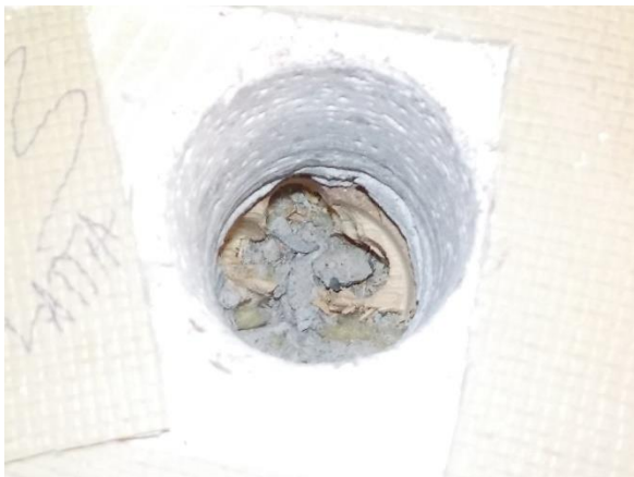
Kuva 3. Yleiskuva rakenneavauksesta RA.03
