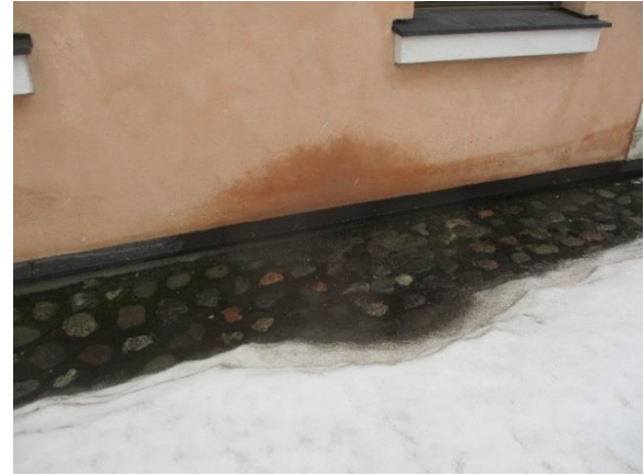
Kuvat 26. ja 27. Sadevesien puutteellinen ohjaus aiheuttaa julkisivurakenteille kosteusrasitusta
