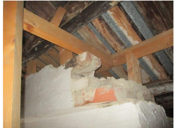
Kuva 17. Yleiskuva ullakon ja vesikaton rakenteista
