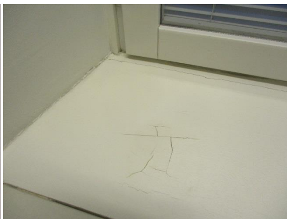
Halkeamia ulkoseinärakenteissa ja rakenneliittymissä, vaurioita ikkunapenkeissä
