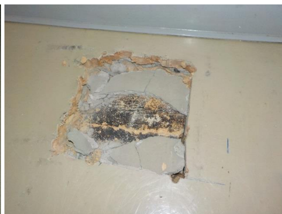
ASB.02, vinyylilaatta ja liima (vasen) ja vanha bitumiliima tms. (oikea)
