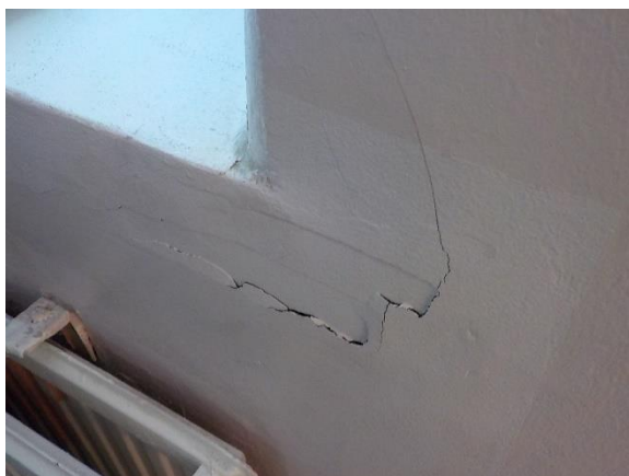
Halkeamia ulkoseinärakenteissa ja rakenneliittymissä, vaurioita ikkunapenkeissä
