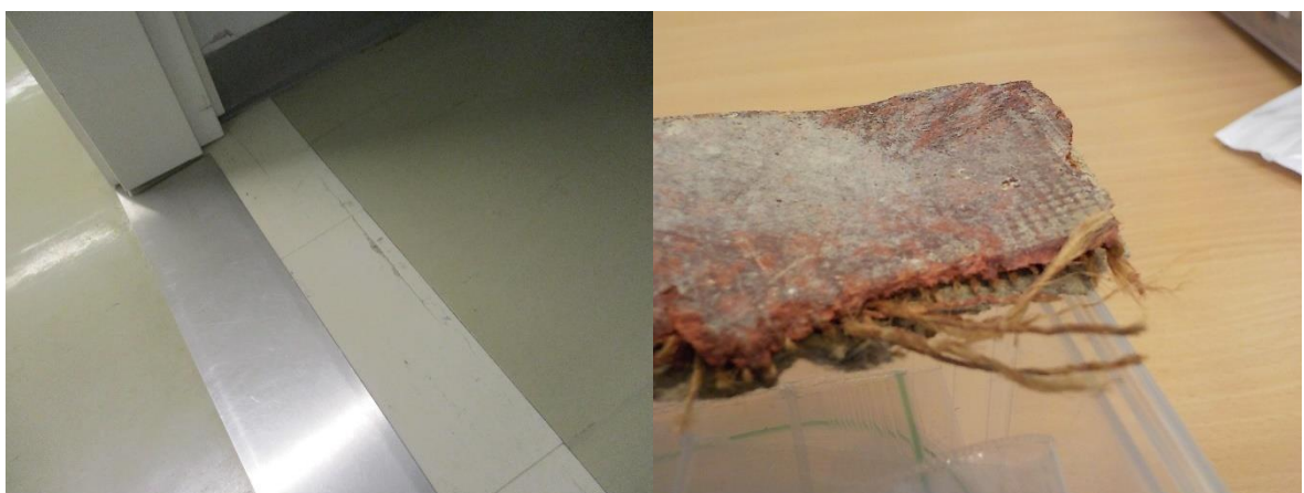
ASB.02 ja ASB.03 Vinyylilaatta ja muovimatto
