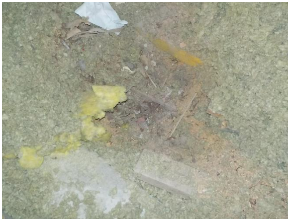
Yleiskuva rakenneavauksesta RA.11 (YP1)
