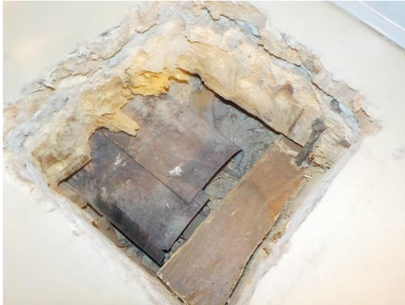
Yleiskuva rakenneavauksesta RA.04 (VP3)
