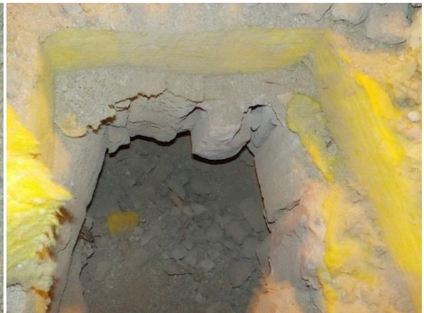
Yleiskuva rakenneavauksesta RA.13 (YP2)
