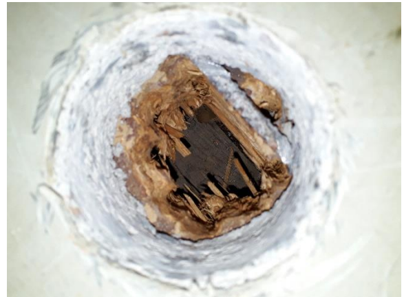
Yleiskuva rakenneavauksesta RA.07 (VP2)
