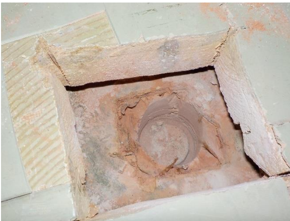
Yleiskuva rakenneavauksesta RA.02 (AP3)
