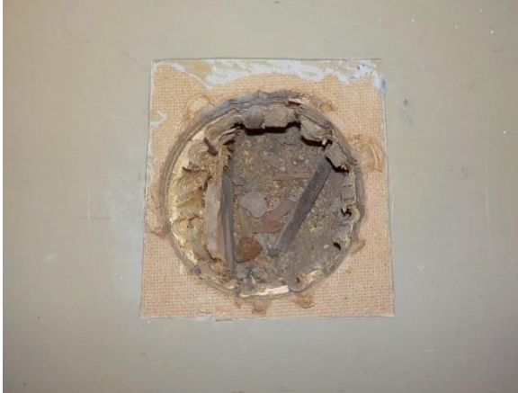
Yleiskuva rakenneavauksesta RA.03 (AP1)
