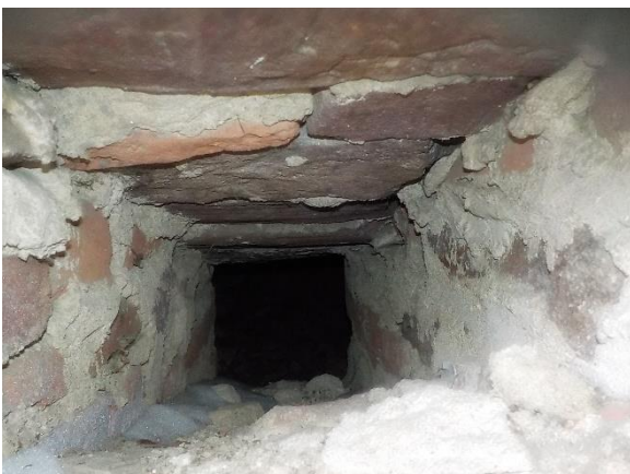
Tuuletusluukku alapohjaan
