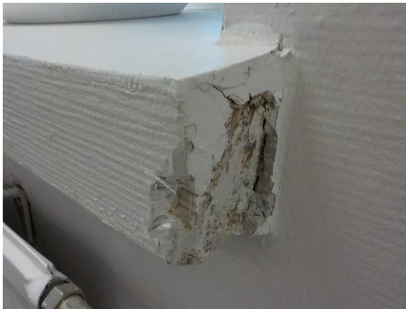
ASB.01 Ikkunapenkki, tasoite ja pinnoite
