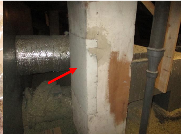
ASB.08 Pilarisuojaus, yläpohja
