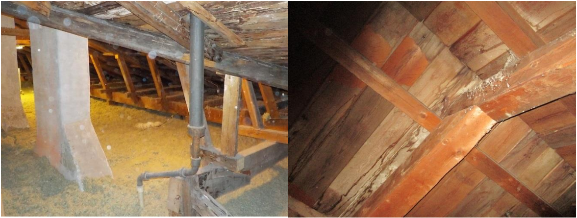
Yleiskuvia yläpohjasta ja vesikatteen aluslaudoituksesta
