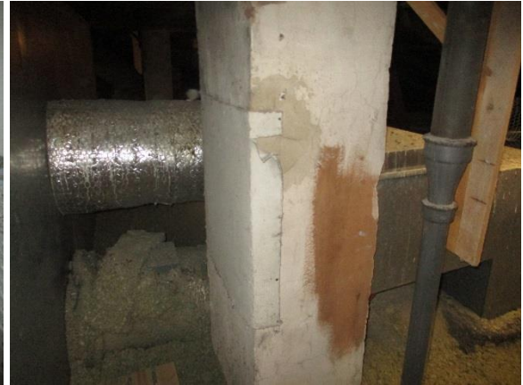
ASB.05, märkätilojen alakattolevy (vasen) ja ASB.08, pilarisuojaus (oikea)
