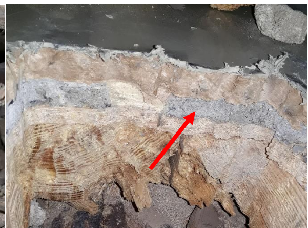
ASB.05 Vanha lattiatasoite + pinnoite, RA.04
