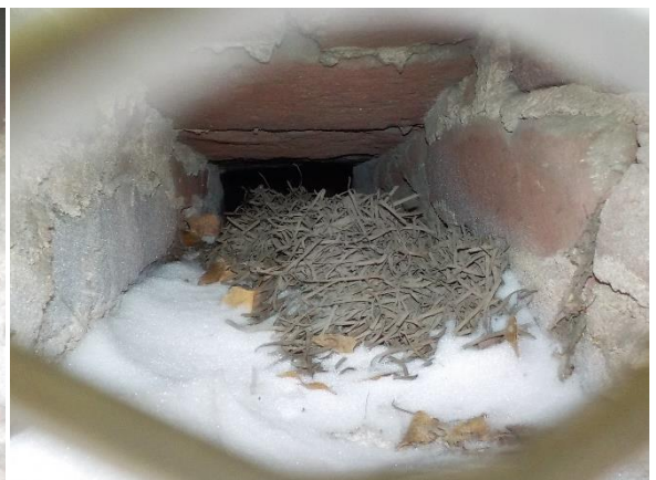
Tuuletusluukut osittain tukkeessa
