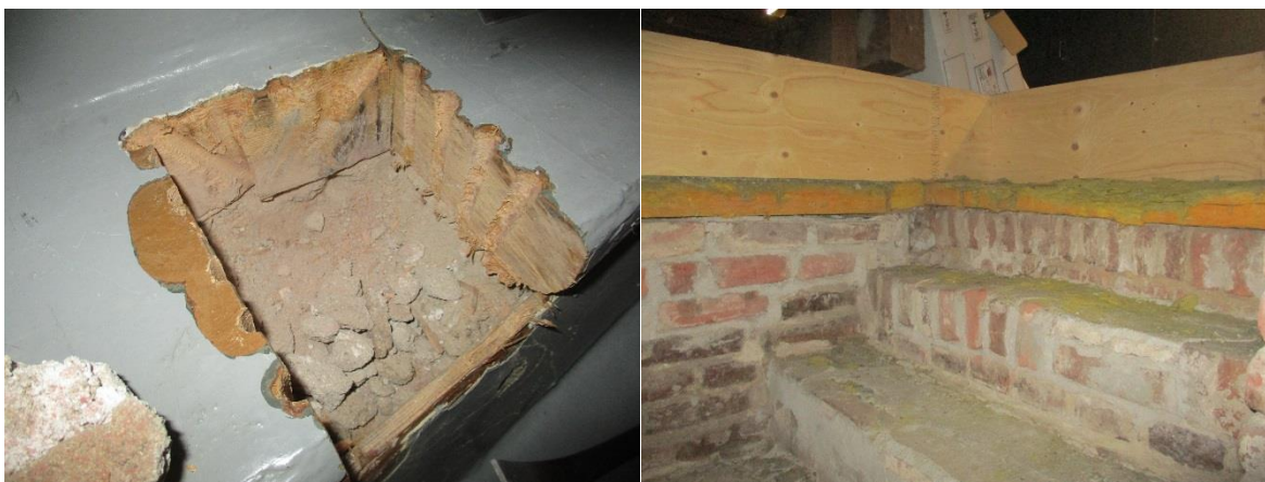
Portaat tiilirakenteisia ja puuverhoiltuja, ullakolle johtavat portaat tiilirakenteisia
