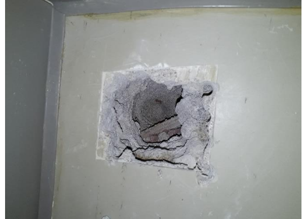
Yleiskuva rakenneavauksesta RA.05 (VP4)
