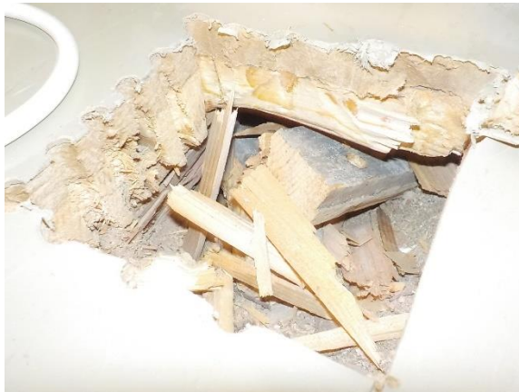
Yleiskuva rakenneavauksesta RA.06 (VP1)
