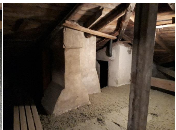
Yläpohjassa mm. vanhoja hormirakenteita, nurkassa vanha nostokoneisto
