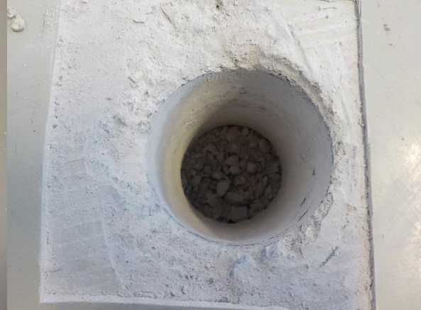
Yleiskuva rakenneavauksesta RA.01 (AP2)
