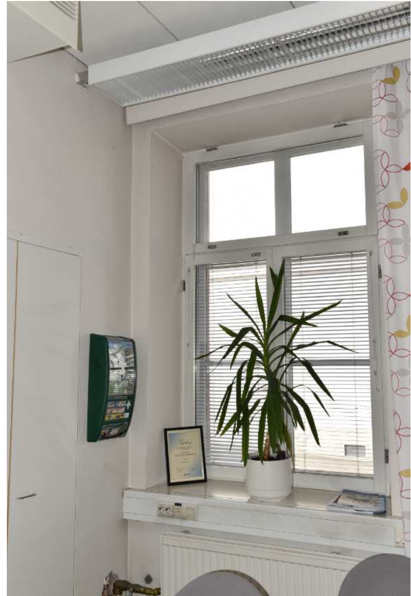
Kuva: Syvät ikkunapenkit ja niiden ulkoreunassa johtokanavat. Yläpuitteessa on yläsaranointi.
