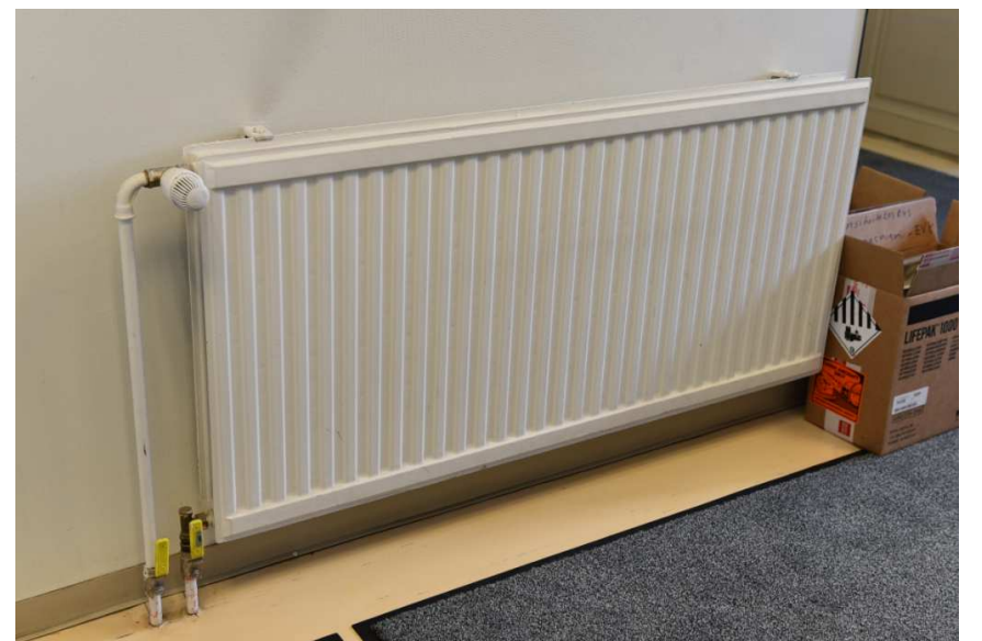
Kuva: Kaikki uunit on purettu ja talossa on 1970-luvulla rakennettu vesikiertoinen keskuslämmitys kalusteineen. Termostaatit on uusittu myöhemmin.
