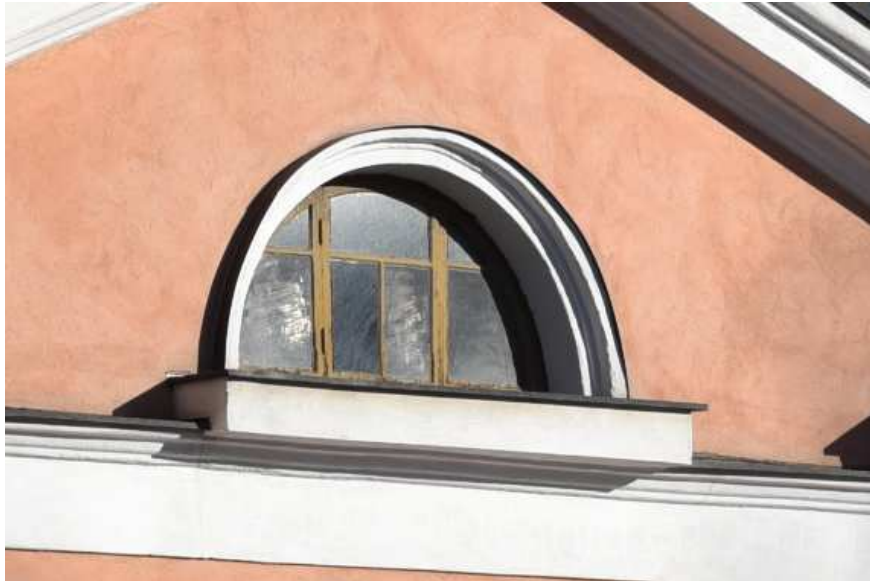
Kuva: Ullakkopäätyjen puolipyöreissä ikkunoissa on säilytetty vanhat puuikkunat. Keskellä oleva T-ikkuna on saranoitu.
