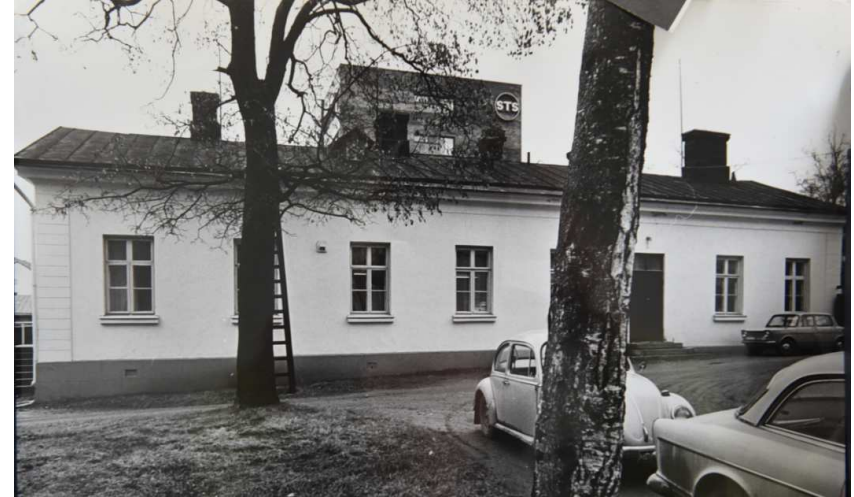
Kuva: Rakennuksen ulkoasu ennen 1975 alkanutta saneerausta: ikkunat ristikarmillisia, ulkopuitteissa vesinokat, rapattu sokkeli seinäpinnan tasossa, nähtävästi pystypaneloidut pariovet, vaalea yleisväritys, syöksytorvet. / Valokuva noin 1974. Keskussairaalan arkisto.
