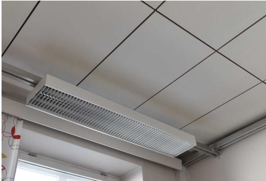
Kuva: Akustokarhulevyillä verhoiltu sisäkatto. Huoneissa ei ole kattolistoja.
