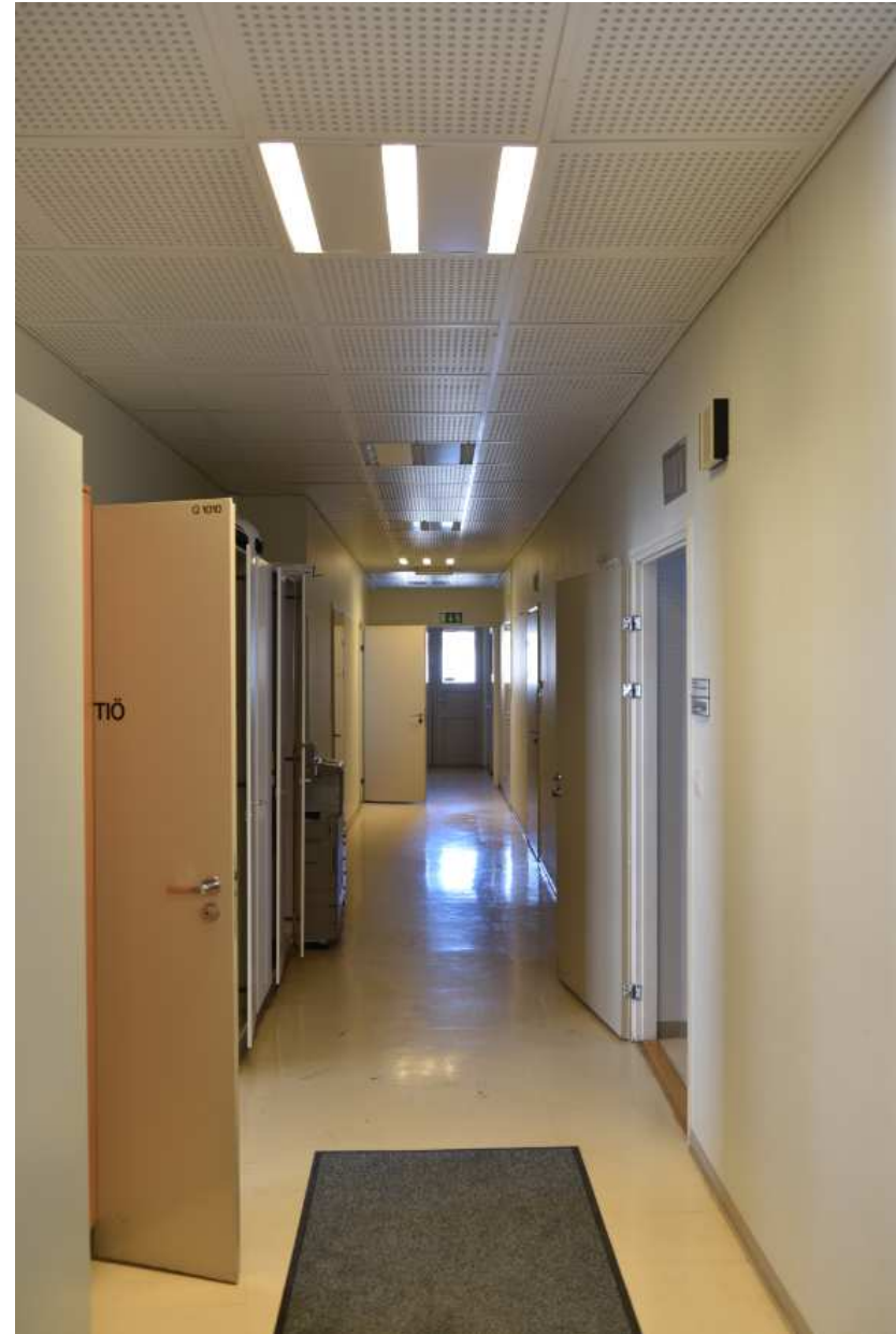
Kuva: Nykyinen pitkä keskikäytävä on tehty 1970-luvun saneerauksessa. Etuosan käytävätila on erotettu entisestä pyykkituvasta. Perällä näkyy alkuperäistä sairausosaston keskikäytävää ja päädyn sisäänkäynti.
