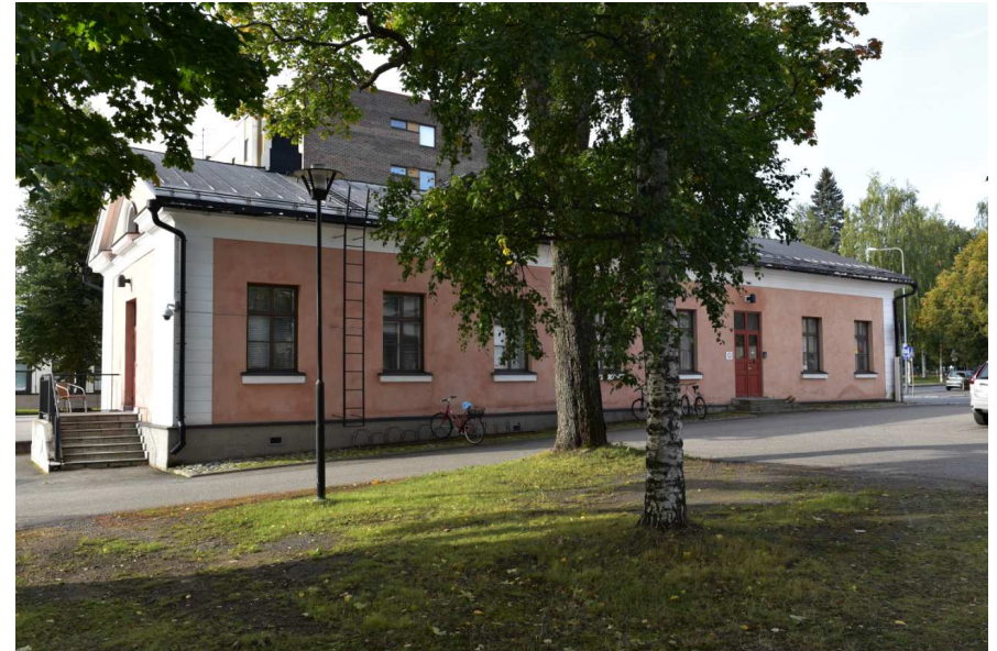
Kuva: Pitkä siipirakennus rajaa näkyvyyden kadulta sairaalan sisäpihalle.
