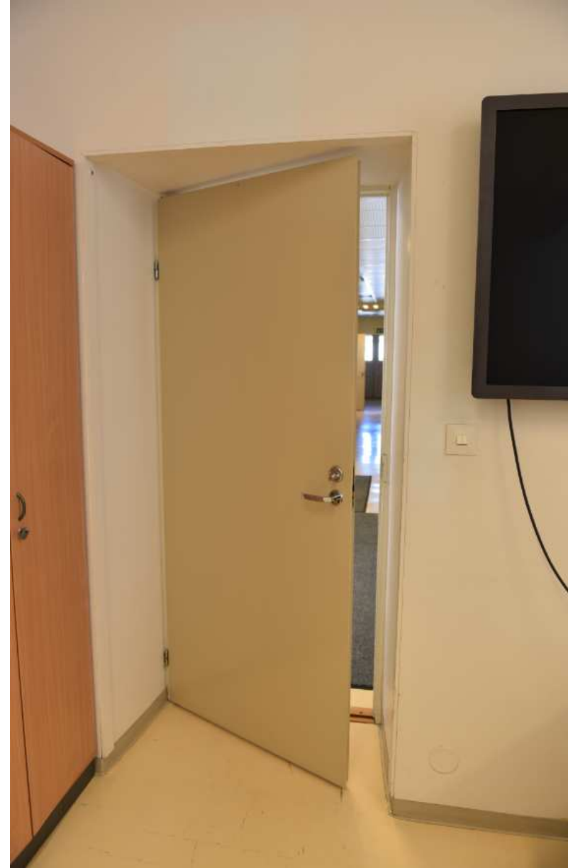
Kuva: Rakennuksen kaikki sisäovet uusittiin 1970-luvun puolivälissä. Oviaukon kohdalla tulee esille tiilestä muurattujen väliseinien jyrkyys.
