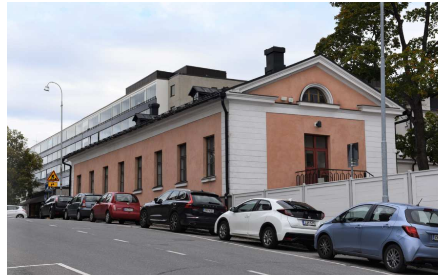
Kuva: Siipirakennus sijaitsee jyrkän rinteän yläreunalla.
