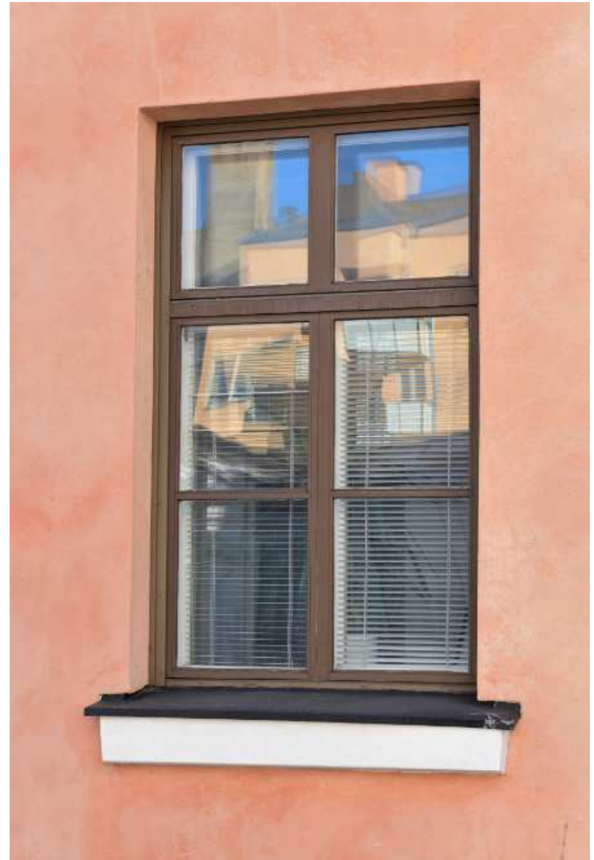
Kuva: 1970-luvulla teetettyjen sisäänaukeavien puikkunoiden ulkopuolteessa säilytettiin alkuperäisenkaltainen ruutujako.
