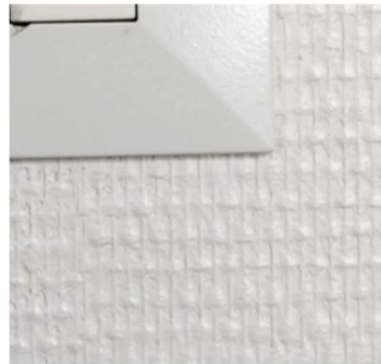
Kuva: Akustokarhulevyillä verhoiltu sisäkatto. Huoneissa ei ole kattolistoja.
