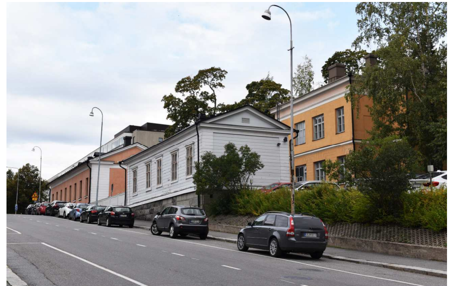
Kuva: Vuorikatu ja Q-, T- ja P-rakennukset.
