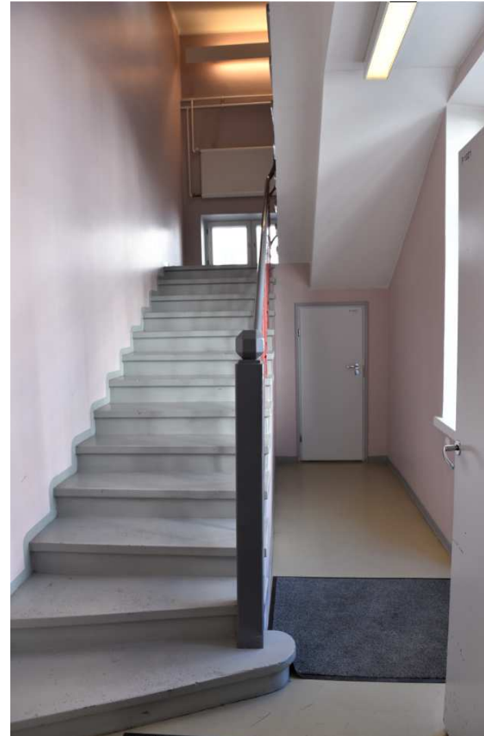
Kuva: Pohjoispäätyyn 1927 valmistunut betonirunkoinen sisäporras.
