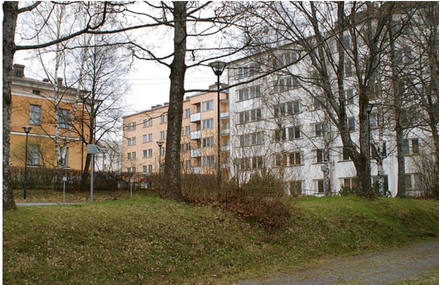
Kuva: Vasemmalla on vanha lääninlasaretti, keskellä 1930-luvun lääninsairaala ja oikealla 1960-luvun alkupuolella valmistunut sairaalarakennus. Kuva on otettu S-rakennuksen pihalta.
