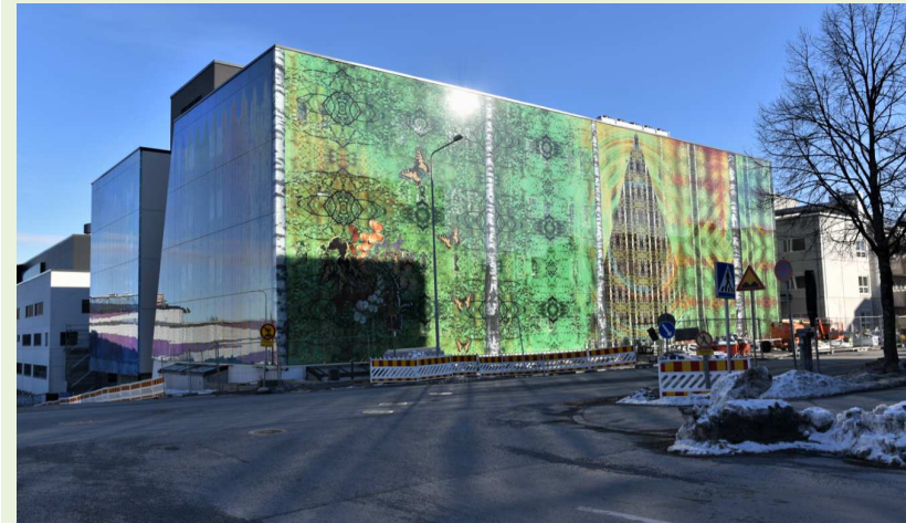
Kuva: Viimeisin lisärakennushanke käynnistyi 2015 ja sen on tarkoitus valmistua 2022. Hanke käsittää sekä uudisrakentamista että nykyisten tilojen saneeraamisen. Rakentaminen tapahtuu pääasiassa entisen sairaalakorttelin sisällä. Viimeiselle palalle Pirttiniemen puistoa on valmistumassa Perhetalo, jonka julkisivut ovat printattua lasia (suunnittelija Lauri Nykopp).
